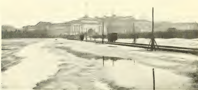
Façade latérale de l'Amirauté du côté du Palais d'hiver.
